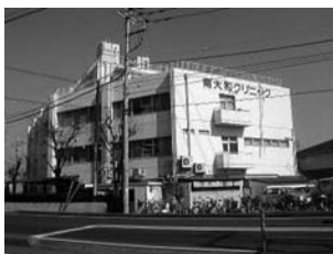
南大和クリニック2階の全通所リハビリテーションセンター
